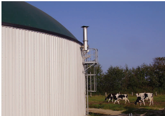
Unité de méthanisation en Allemagne
