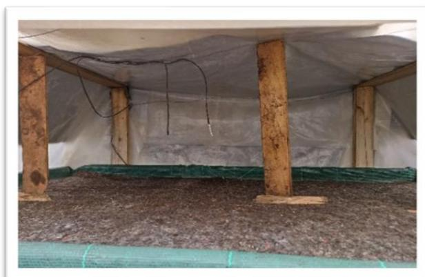
*Étuve (vide à cette date). Enveloppée d'une couverture et d'isolant. Une nappe chauffante thermostatée contrôle la température.*
